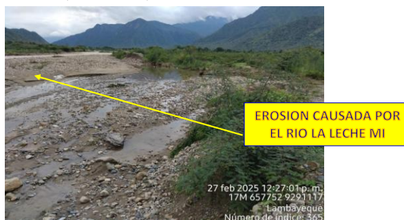
FIGURA N°03: SECTOR EL PALTO, EROSION CAUSADA POR EL RIO LA LECHE EN LA MARGEN IZQUIERDA AGUAS ABAJO, SE PROYECTA DEFENSA RIBEREÑA
